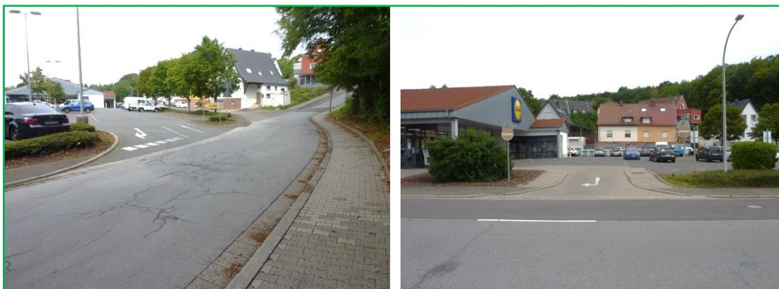
**Bild 5: Vollanschluss Wingerathstraße und Richtungsanschluss Kreisstraße**
